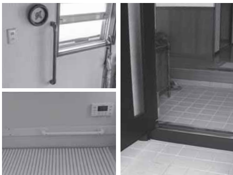
左上:玄関手摺 左下:ユニットバス手摺 右:玄関ドアの取替え
